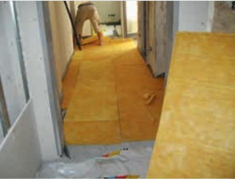
16 Trittschalldämmplatten werden verlegt
