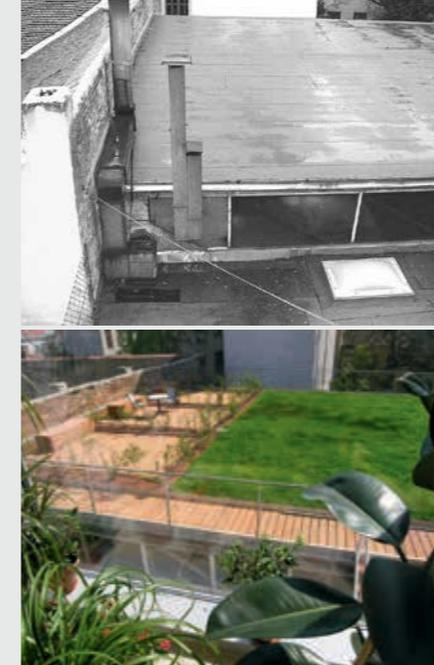
9, 10 Flachdach eines Hofgebäudes vor und nach Sanierung
