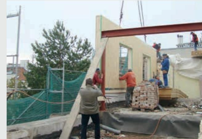
11 vorgefertigte Holzelemente werden montiert
