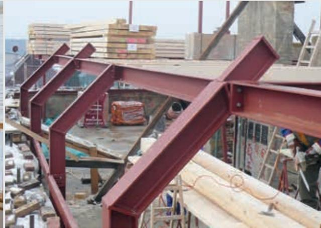
10 Stahlrahmenkonstruktion für Aufstockung
