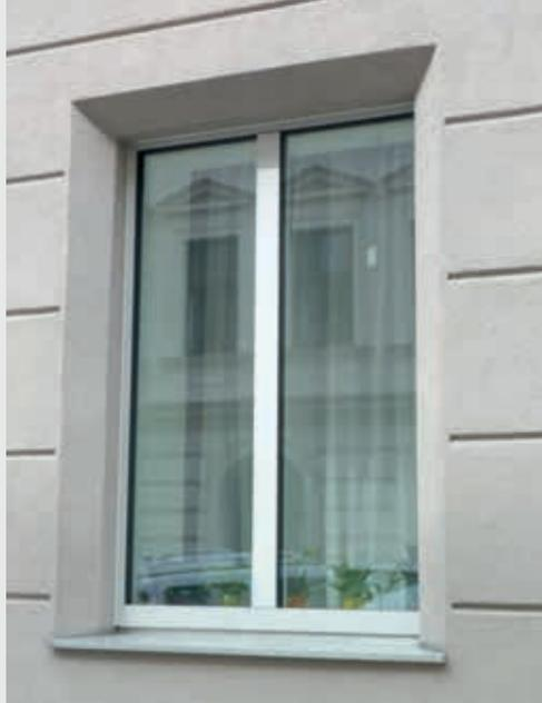
12 verbesserter Lichteinfall durch Abschrägung der Wärmedämmung in der Fensterleibung
