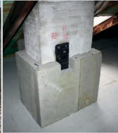
23 Dachbodendämmung mit Anschlussdämmung der Kaminmauer
