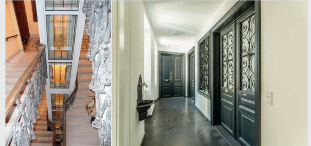
8 Liftschachtlösung in einer adaptierten Stiegen spindle
