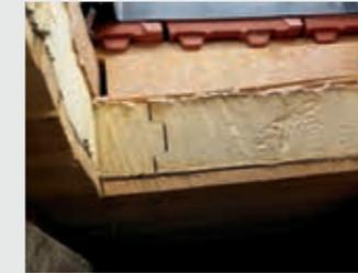
5 Wärmedämmung beim Einbau eines Dachflächenfensters
