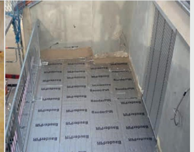
11 Dämmung der Terrassen mit Vakuumdämmplatten
